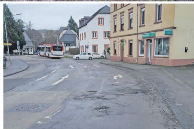
Buckelpisten. Große Schlaglöcher und beschädigtes Pflaster: In der Ruwerer Straße (Bild oben und rechts unten) sowie in der Konstantinstraße stehen in diesem Jahr noch Sanierungen des Straßenbelags an. Fotos: StadtRaum Trier
