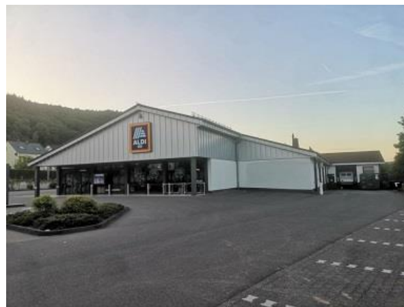
Abbildung 12: Südseite des Aldimarktes
