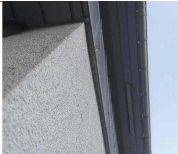
Abbildung 28: dicht verschlossene Dachrandverblendung
