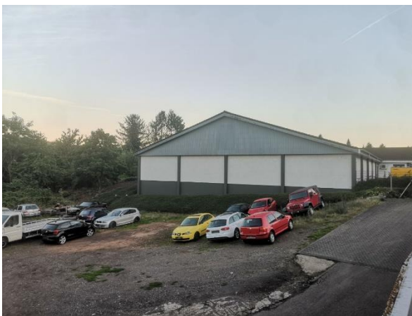
Abbildung 17: Parkplatz zwischen Aldimarkt und Autowerkstatt
