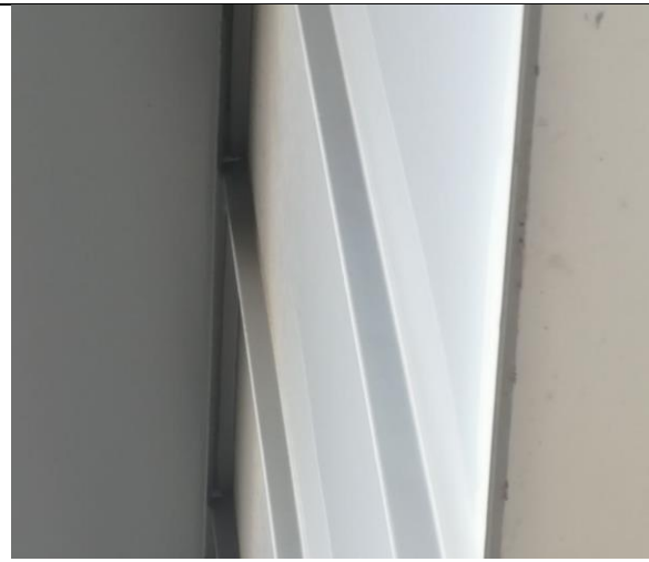
Abbildung 29: dicht verschlossene Dachrandverblendung
