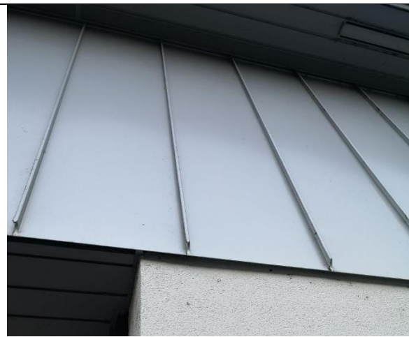
Abbildung 31: dicht verschlossene Dachrandverblendung
