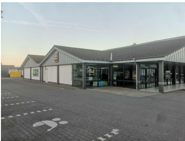
Abbildung 11: Westseite des Aldimarktes
