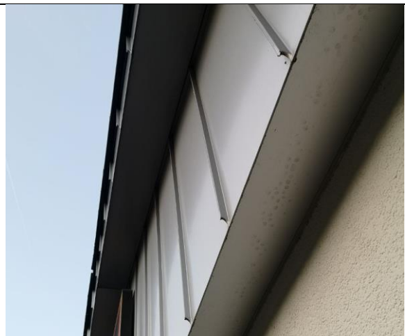
Abbildung 30: dicht verschlossene Dachrandverblendung
