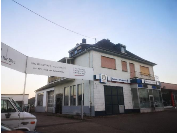
Abbildung 15: Autowerkstatt mit angegliedertem Wohnhaus
