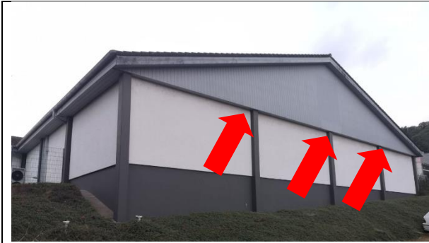
Abbildung 26: Giebelseite (Aldi) im Osten mit potentielle Spaltenquartieren (rote Pfeile)
