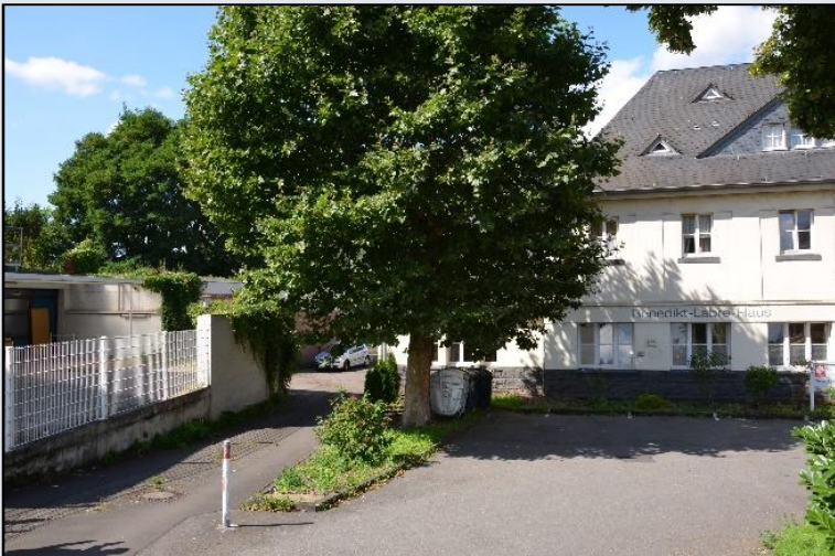
Zugang von Luxemburger Straße
