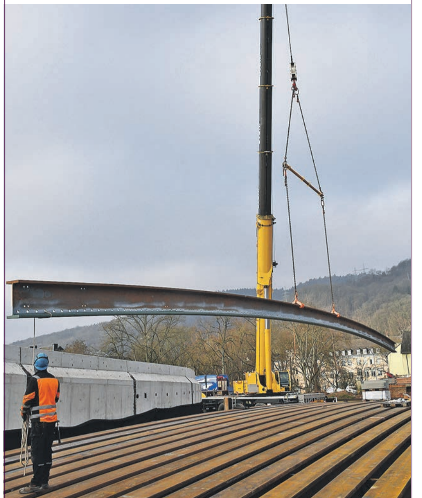
Zum Neubau der Eisenbahnüberführung in Trier-West werden seit Mitte Februar mit Schwertransporten aus einem Werk des Konzerns ArcelorMittal in Luxemburg Nacht für Nacht Stahlträger angeliefert und auf der Baustelle zwischengelagert. Der letzte der Konvois, die neben zwei Transportern aus drei Begleitfahrzeugen und einer Polizei-Eskorte bestehen, ist für 19. März geplant. Ab April werden die 38 Meter langen, leicht gebogenen Elemente eingebaut und schaffen die Verbindung zwischen den bereits weitgehend fertiggestellten Widerlagern zu beiden Seiten der Bahnlinie. Gleichzeitig macht der Bau der Stützmauer (im Bild links) für die westliche Auffahrtsrampe der Brücke gute Fortschritte. Foto: PA/kgig
