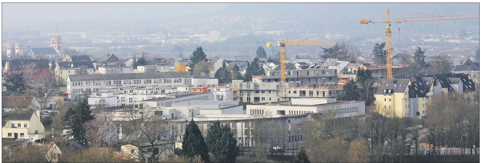
Großprojekt. Der Süden des Stadtgebiets hat seine Spitzenstellung bei den Bodenpreisen ausgebaut. Die Baukräne in Heiligkreuz (rechts) gehören zu einer großen Wohnanlage im Klostergarten. Neben den derzeit besonders nachgefragten Eigentumswohnungen entstehen dort auch Penthäuser. Foto: PA
