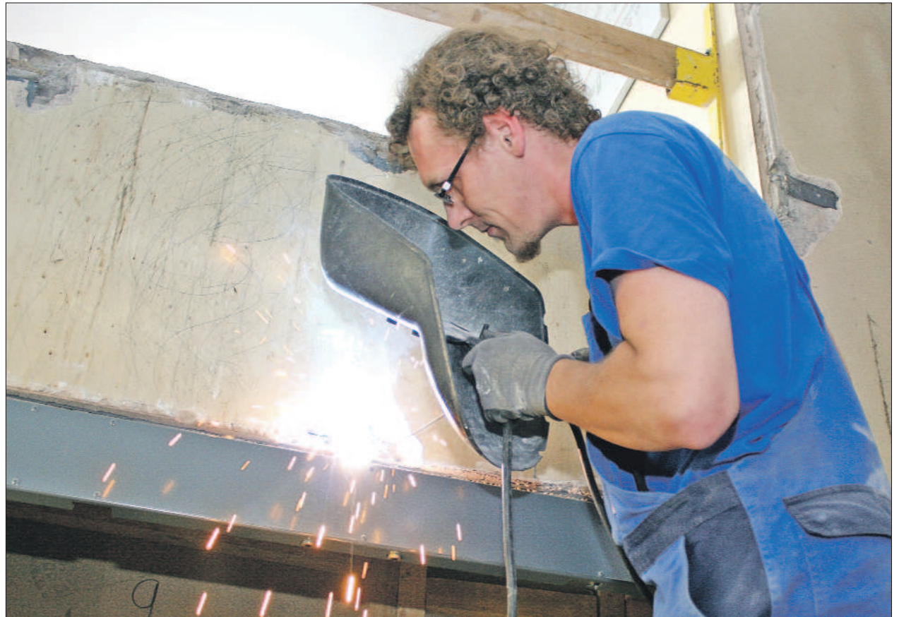
Schweiß-Arbeit. Harald Kirstgen von der Firma Trierer Aufzugbau lässt beim Anpassen des Türrahmens im neuen Lastenaufzug des Theaters die Funken fliegen. Foto: PA
