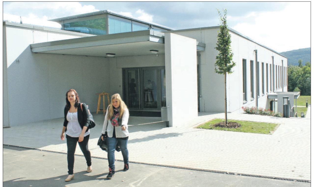
Doppelseingang. Zwei Schülerinnen verlassen den Mensatrakt durch den oberen Eingang. Der zweite Zugang (hinten rechts) zu dem geschickt in den Hang eingefügten Gebäude führt in die Sporthalle.
