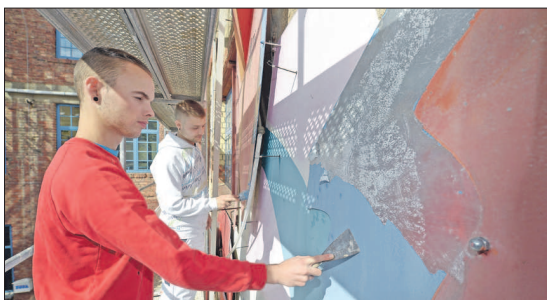
Auffrischung. Bevor das Kunstwerk an der Fassade über dem Tufa-Haupteingang aufgefrischt wird, entfernen die Maler-Azubis Philipp Schmidt und Kevin Zimmermann verwitterte Farbschichten. Foto: LA 21
