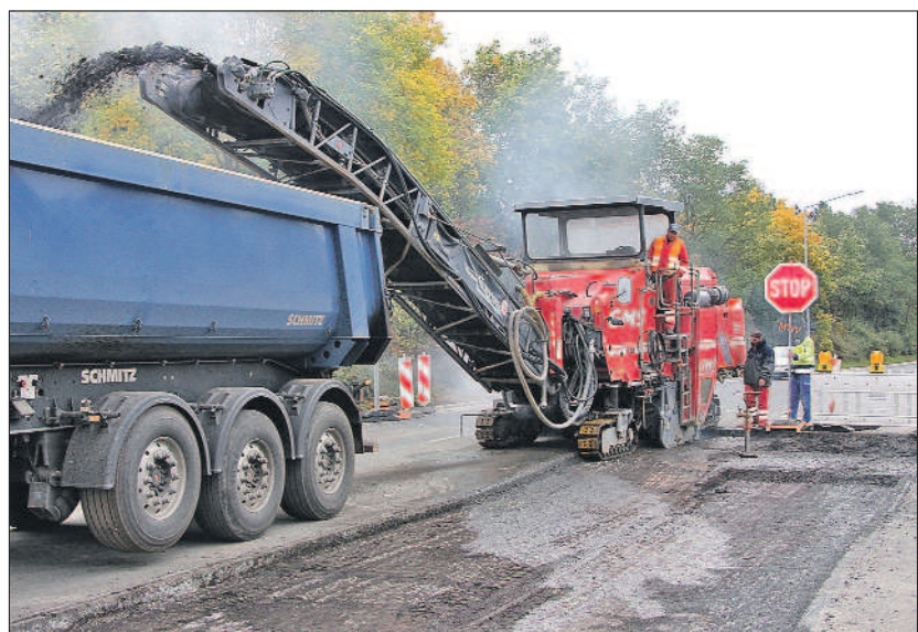
Maßarbeit. Zum Abtransport der abgefrästen Asphaltbefestigungsschicht steht jeweils ein Laster in der Nähe der Maschine. Foto: PA
