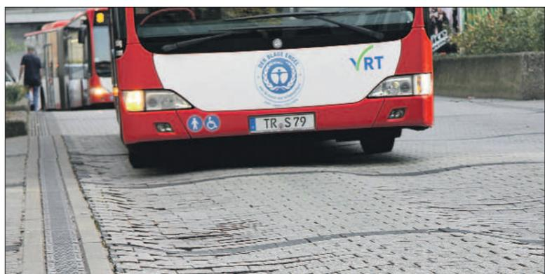
**Die Welle.** Die viel befahrene Busspur an der Treviris-Passage muss wegen Spurrillen und lockeren Pflastersteinen dringend instandgesetzt werden. Foto: PA
