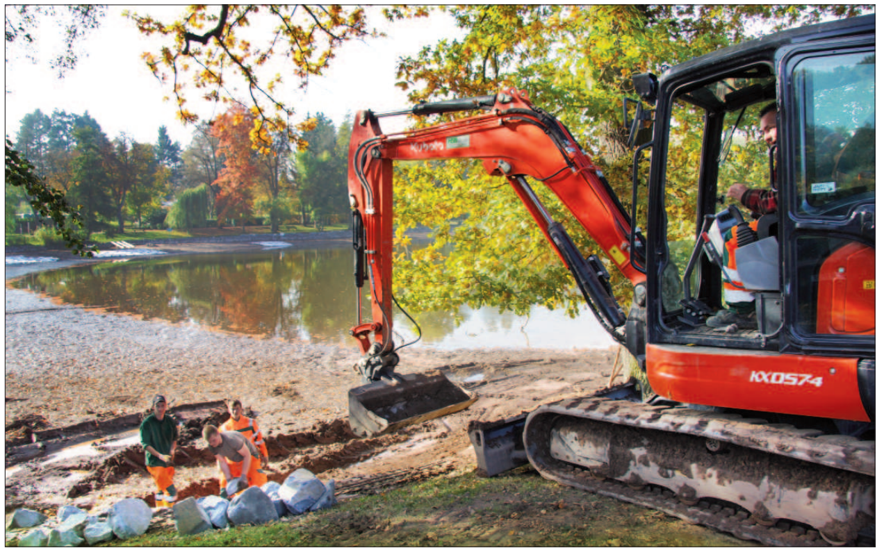
Weil die Ufer am Caspary-Weiher in Feyen/Weismark über die Jahre stark erodiert sind, setzt das Grünflächenamt in Kooperation mit dem Angelsportverein Trier-Süd die Uferbefestigung wieder instand. Durch Bodenerosion waren die Wurzeln der Ufergehölze freigespült worden und immer wieder Bäume umgestürzt. Um weitere Unterspülungen zu vermeiden und vorhandene Bäume zu sichern, werden voraussichtlich bis 9. November Wasserbausteine aus Basalt (Foto) sowie in einzelnen Abschnitten Weidengeflecht gesetzt. Nachdem im Herbst 2011 bereits das Südwestufer stabilisiert wurde, wird in diesem Jahr auf einer Strecke von etwa 150 Metern am Nordostufer gearbeitet. Foto: PA
