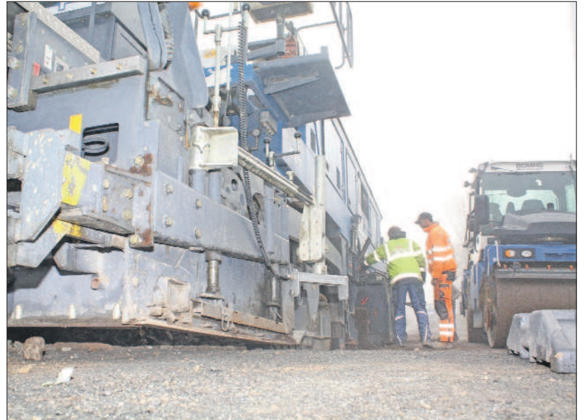
Spezialgerät. Der 40 Meter lange Stahlkoloss nimmt die beschädigte Asphaltdecke auf und verwendet sie bei der Erstellung des neuen Belags wieder. Von der Hightech-Maschine gibt es in Deutschland nur drei Exemplare. Fotos: PA
