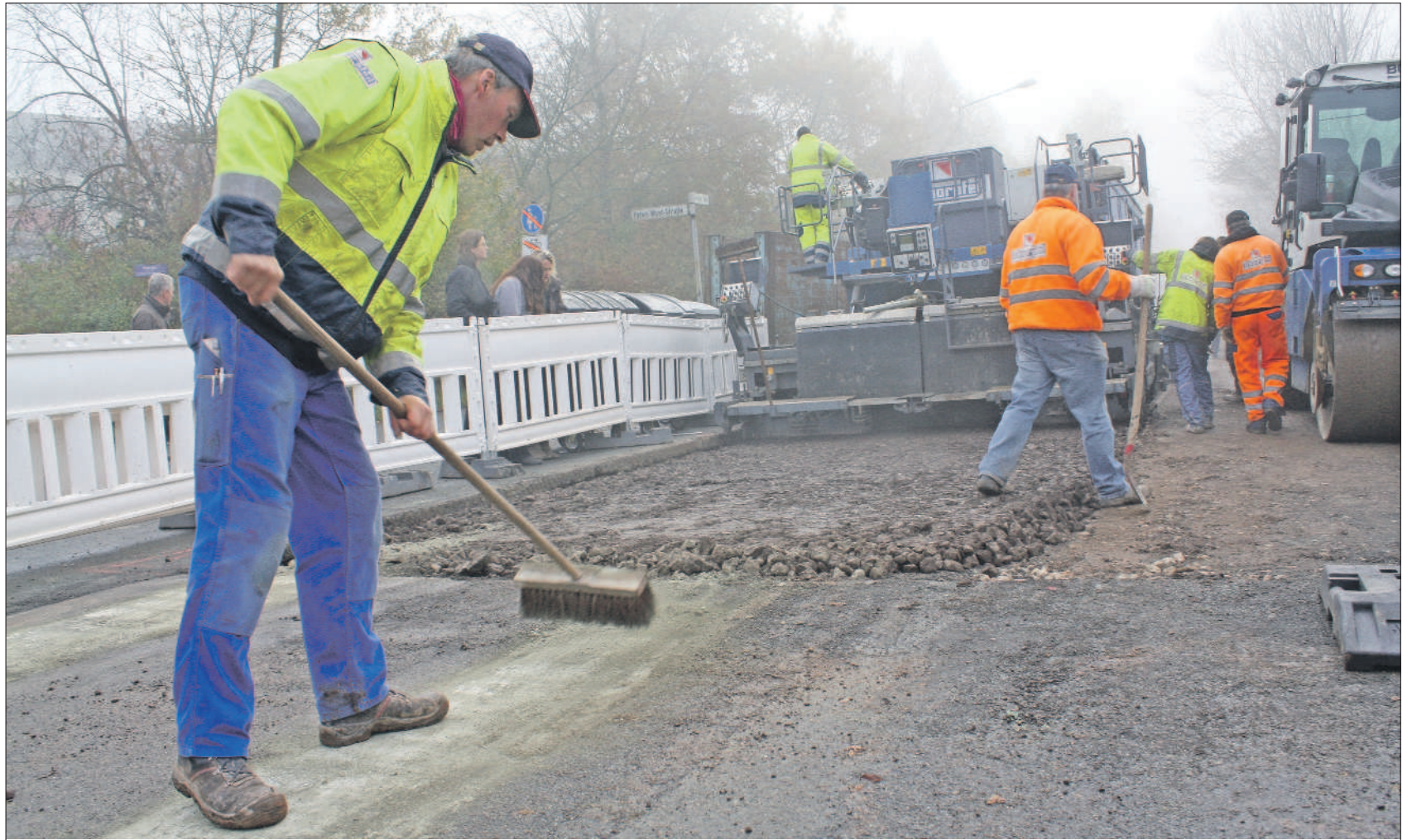
Kehraus. Nachdem der neue Belag aufgetragen ist, säubern Bauarbeiter die Fahrbahn.
