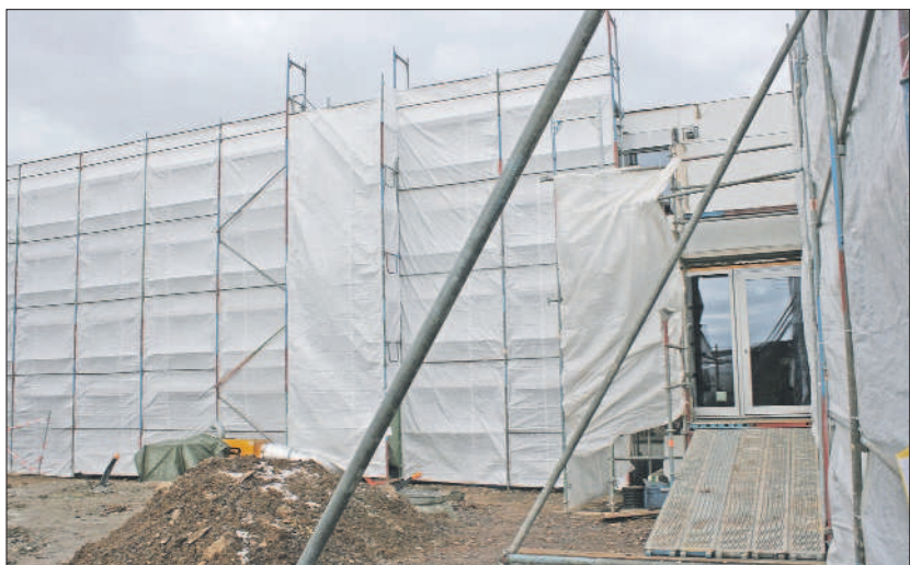
Trockenphase. Derzeit verschwindet das künftige Kita-Gebäude fast komplett hinter Schutzplanen. Gleichzeitig läuft auf dem Innenhof das Heizungsgebläse auf Hochtouren, um Fortschritte bei der Trocknung zu erreichen. Foto: PA
