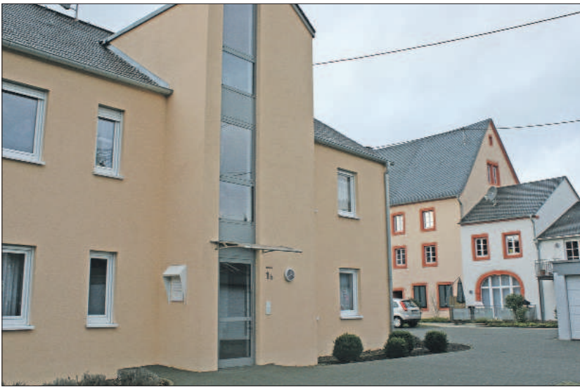
Mangelware. In den letzten Jahren waren im Sozialen Wohnungsbau nur wenige Um- oder Neubauten möglich. Zwei Beispiele von Genossenschaften sind die sanierte Häuserreihe Im Schankenbungert im Trierer Westen (Bild oben) sowie der Neubau in der Münzstraße im historischen Pfälzeler Ortskern. Fotos: PA
