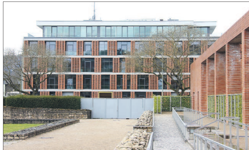
Neues Domizil. Die Bundespolizei bezieht offiziell ihre neuen Büros in einem umgestalteten Gebäude der Stadtwerke in der Weberbach. Der Regionalversorger hatte rund 4,7 Millionen in die Sanierung und Erweiterung des Komplexes investiert. Die auffällige Fassade in unmittelbarer Nähe der Kaiserthermen ist einem römischen Säulengang nachempfunden. (18. April)
