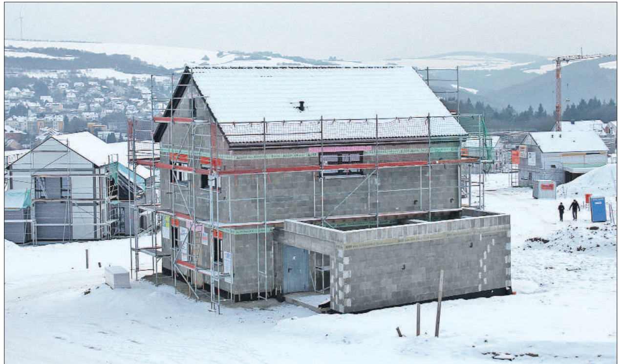
Neue Nachbarn. Die ersten Familien haben im Baugebiet BU 13 mit der Errichtung ihrer Häuser begonnen. Das Grundstück der künftigen Kita liegt ebenfalls im unteren Teil des Geländes, der aber auf diesem Bildausschnitt nicht mehr zu sehen ist. Foto: PA
