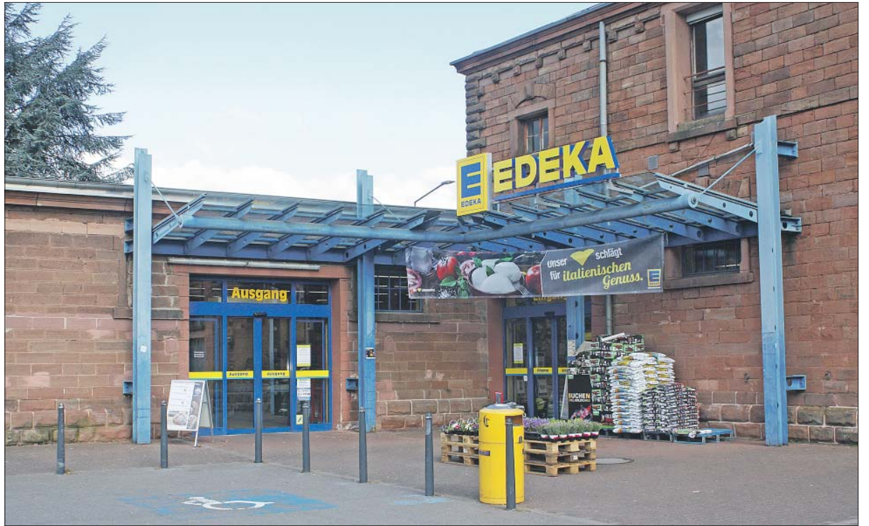
Umtausch. Der Edeka-Markt an der Schöndorfer Straße befindet sich in der rund 120 Jahre alten Reithalle der früheren Maximinkaserne. Jetzt gibt es Pläne für eine Umsiedlung und Vergrößerung des Nahversorgers. Foto: Presseamt/lg
