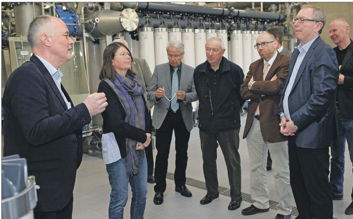
Trinkwasserfabrik. SWT-Wasserwerksleiter Christian Girndt (l.) zeigt Umweltministerin Ulrike Höfken (2. v. l.) und weiteren Gästen die moderne Aufbereitungsanlage in Irsch. Foto: SWT
