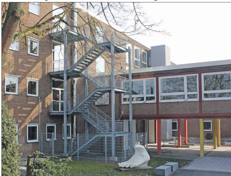
Vorreiter. Im Friedrich-Wilhelm-Gymnasium wurde bereits 2012 eine Außentreppe angebaut, um einen zweiten Rettungsweg zu schaffen. Foto: PA
