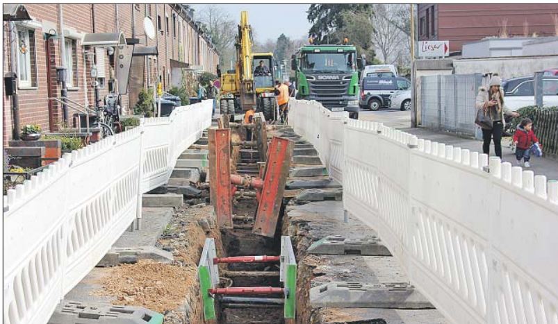
Aufriß. Vor Beginn des Straßenausbaus erneuern zur Zeit die Stadtwerke das Leitungsnetz in der Gärtnerstraße. Foto: PA
