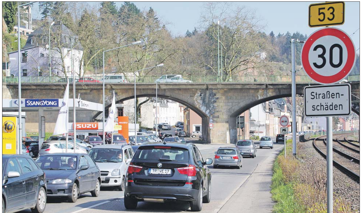
Westtrasse. Obwohl sie als Bundesstraße klassifiziert ist, gilt in der Bonner Straße in Pallien weiterhin Tempo 30. Diese Ausnahmeregelung ist aber nur wegen der starken Straßenschäden möglich. Foto: PA
