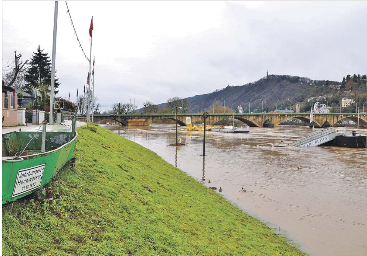
Bollwerk. Beim Moselhochwasser von 2011 war der Zugang zu den Schiffsanlegern in Zurlauben überschwemmt, der obere Schutzdeich aber nicht gefährdet. Ab Herbst 2016 wird das Bauwerk zusätzlich befestigt. Archivfoto: PA
