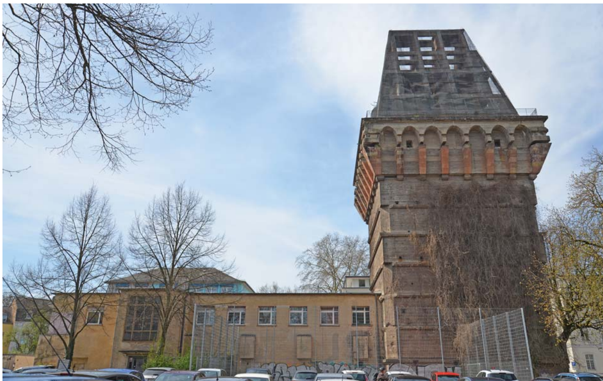
Klima-Schutzbau. Der Hochbunker am Augustinerhof und sein Nebengebäude ist als Standort für eine Nahwärmezentrale mit Blockheizkraftwerken im Gespräch. Foto: Presseamt/pe
