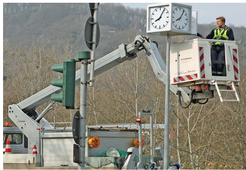
Ticktack. Die neue Uhr steht nicht mehr auf der Brücke, um bei Wartungsarbeiten nicht die komplette Fahrbahn zu blockieren. Foto: SWT
