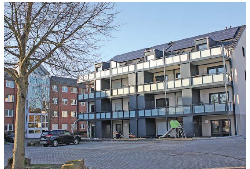
Neubau. Zu den von der ISB 2020 in Trier geförderten Projekten gehören zwei neue Gebäude mit insgesamt 34 Wohnungen in direkter Nachbarschaft des Finanzamts in Trier-Süd. Neben Darlehen über 3,4 Millionen Euro gab es hier Tilgungszuschüsse von knapp 0,8 Millionen Euro. Archivfoto: PA/pe
