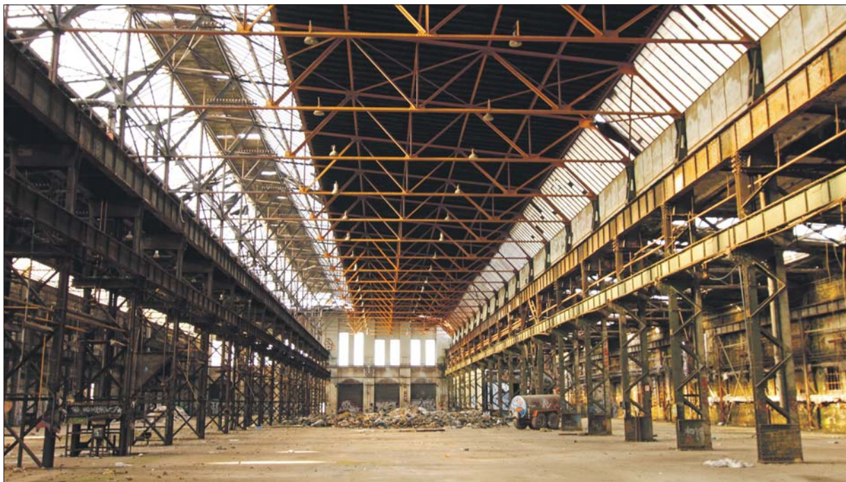
Filigranes Gestänge. Der Blick in den lichtdurchfluteten Innenraum der dreischiffigen Lokrichthalle verdeutlicht das Potenzial des Industriedenkmal für eine moderne Nutzung. Foto: Hochschule Trier, Fachrichtung Architektur
