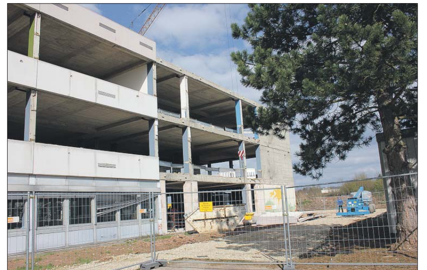
Großbaustelle. Bei der seit 2010 laufenden IGS-Generalsanierung wird derzeit unter anderem das Gebäude C entkernt. Damit der Unterricht in allen Jahrgangsstufen einschließlich der neuen Oberstufe ungestört stattfinden kann, geht im Herbst ein mobiles Holzmodulgebäude in Betrieb. Foto: Presseamt
