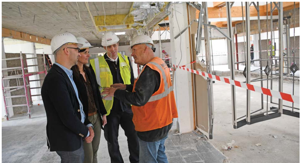
Auf der Baustelle. Abbruchunternehmer Hein Heun (r.) tauscht sich mit dem Projektteam, bestehend aus Andreas Kardelky (Stadtwerke), Martina Piry (Hochbauamt) und Thorsten Petry (Berufsfeuerwehr, v. l.), aus. Foto: Presseamt/gut
