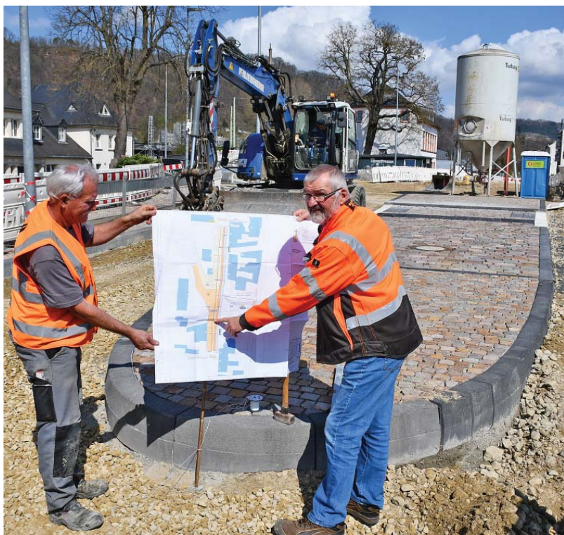
Tragfähig. Bauleiter Karl-Alois Romberg vom StadtRaum Trier und Willi Mertes, Mitarbeiter der Straßenbaufirma Schnorpfel, besprechen die anstehenden Asphaltarbeiten am Römerbrückenkopf. Foto: Presseamt/kig
