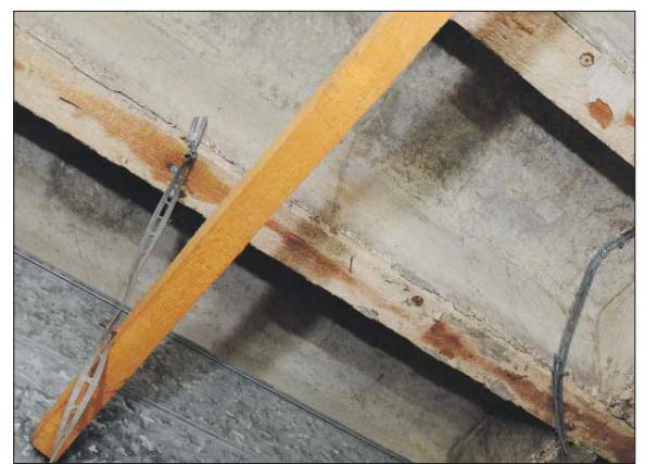
Ortstermin. Gutachter Bruno Isstas erläutert Wolfram Leibe und Angelika Birk (v. l.) die von unten sichtbaren Schäden an der abgehängten Decke in der für Ballsportarten gesperrten Schulturnhalle des FWG. Das kleine Bild zeigt ein typisches Beispiel für die vielfach unfachmännisch ausgeführten Deckenaufhängungen.
