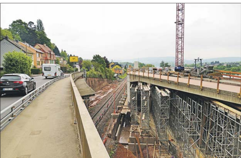
Noch freie Fahrt. In dieser Woche können die Autofahrer die B 49 bei Igel noch wie gewohnt nutzen. Die neue Trasse über den Gleisen (r.) ist bereits gut erkennbar. Foto: PA
