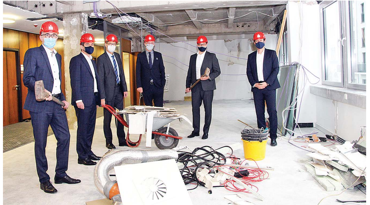
Baustart. Landrat Günther Scharz und OB Wolfram Leibe (3. und 4. v. l.) schwingen als Vertreter des Verwaltungsrats der Sparkasse zusammen mit dem Vorstand und Projektleiter Thomas Schmidt (rechts) den symbolischen Abrisshammer in einem Büro in der ersten Etage, das teilweise schon entkernt wurde. Foto: Sparkasse
