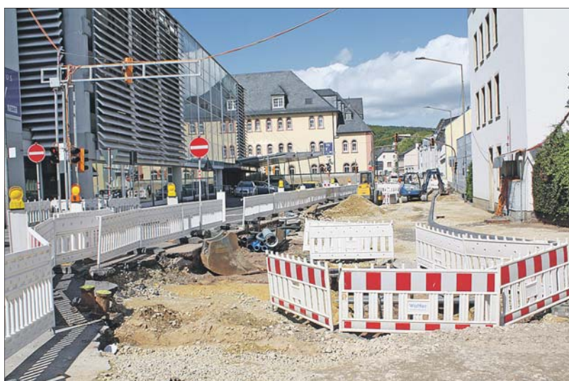
Untergrund. Die Ecke Justiz- und Böhmerstraße ist wegen der Ausbauarbeiten schon seit mehreren Wochen gesperrt. Ab Mittwoch wird das Baufeld vergrößert. Foto: Presseamt/kg
