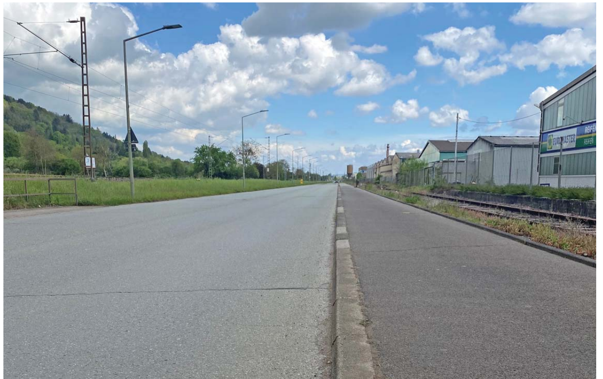
Neuer Standort. Der Straßenstrich soll von der Ruwerer- in die Gottbillstraße nach Euren verlegt werden. Hier sollen auch ein Aufenthaltsraum und eine sanitäre Anlage für die Sexarbeiterinnen entstehen. Foto: Presseamt/gut
