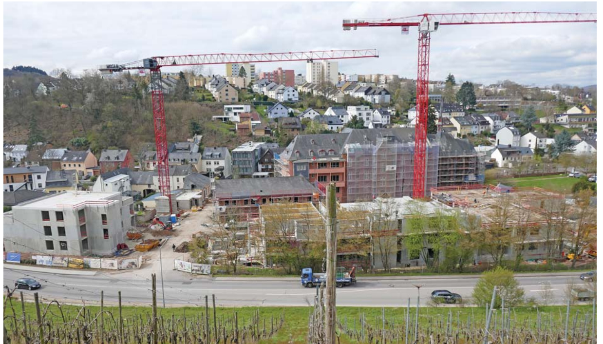
Etappen. Der Blick vom Fuß des Petrisbergs auf Olewig zeigt rund 50 Jahre alte Wohngebäude oben am Berg, die überwiegend historische Baubsubstanz im Ortskern und im Vordergrund das aktuelle Großprojekt im Klostergarten. Dort entstehen zahlreiche neue Wohnungen. Foto: Amt für Bodenmanagement und Geoinformation/Mario Panser
