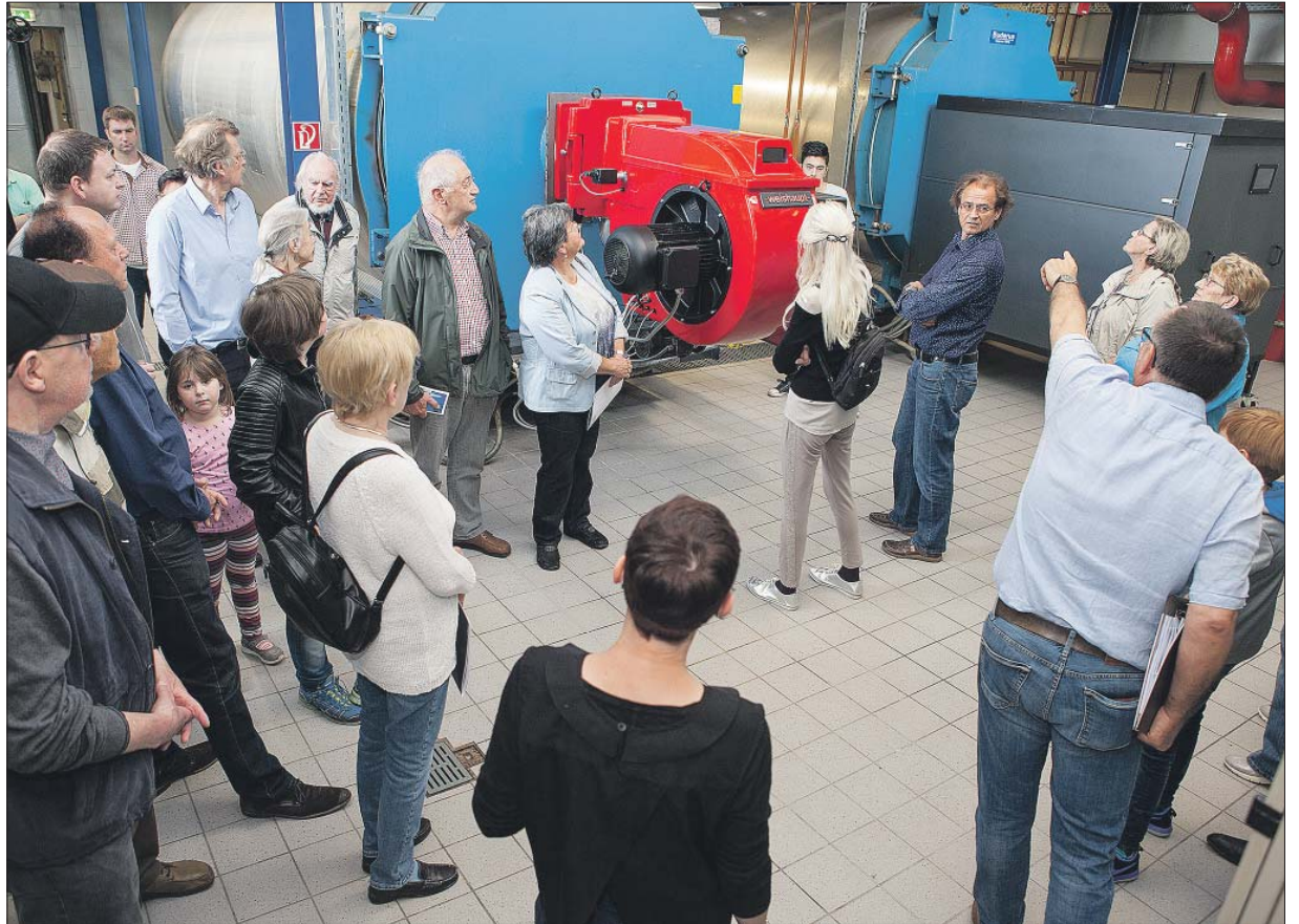
Ortstermin. Stadtwerke-Mitarbeiter Markus Paul führt beim Tag der offenen Tür interessierte Besucher verschiedener Altersgruppen durch das Heizkraftwerk in Mariahof.
