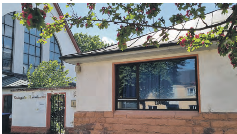
Mitten im Viertel. Der Eingang zu dem Gebäudekomplex, der unter anderem die Kita umfasst, liegt in der Ambrosiusstraße im Zentrum von Trier-Nord. Links ist die Kirche St. Ambrosius zu sehen und auf der anderen Seite des Grundstücks grenzt das Bürgerhaus Trier-Nord an. Foto: Presseamt/pe
