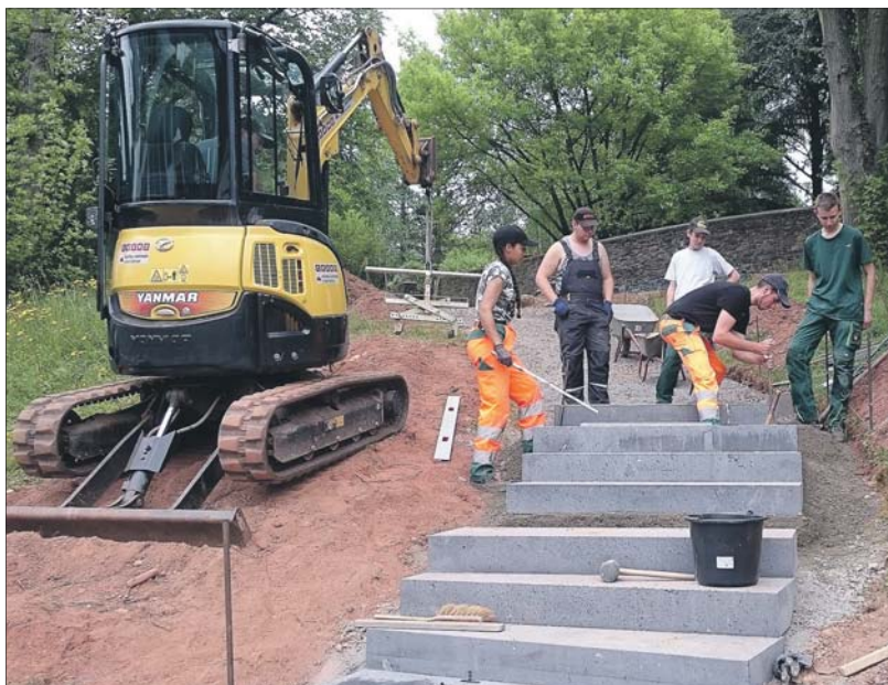
Neuer Aufgang. Die Landschaftsgärtner-Azubis bauen zusammen mit den Praktikanten die Stufen auf dem Hanggrundstück in Ruwer ein. Für die Erdarbeiten ist auch ein Bagger im Einsatz. Foto: Grünflächenamt
