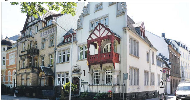
Zwei Eingänge. Der vordere Teil des Haus Franziskus ist über die Christophstraße (1) erreichbar. Der barrierefreie Zugang zum Kutscherhaus (2) im hinteren Teil des Gebäudekomplexes liegt in der Kochstraße. Archivfoto: PA
