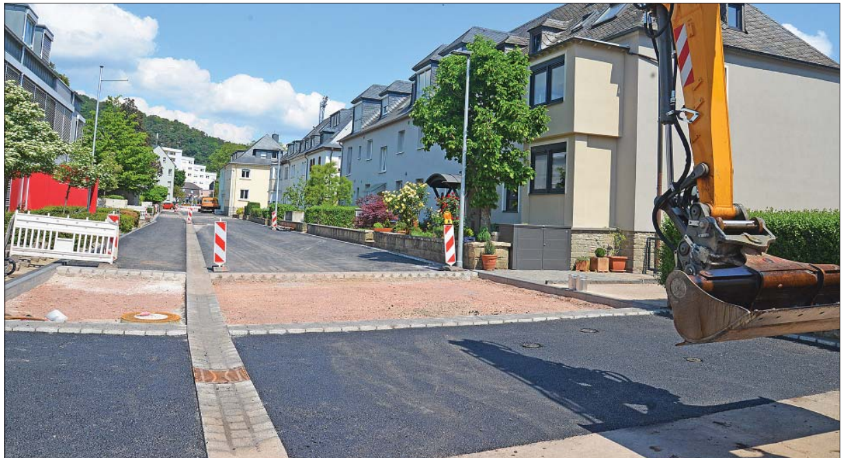
Geteert und gepflastert. Die Mittelrinne zur Entwässerung gehört zu den Gestaltungselementen beim Ausbau der Benediktinerstraße. Der Blick geht in Richtung Wilhelm-Leuschner-Straße, die ab 2. Juni gesperrt ist. Foto: PA/kig
