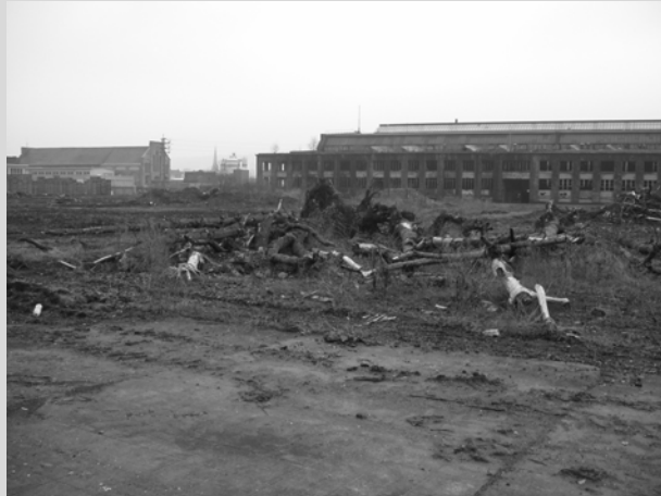
Bild 28: Zerstörung der kompletten Außenanlagen des Ausbesserungswerks durch Räumungsarbeiten
