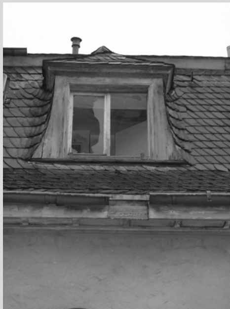
Bild 25: Zustand des Gebäudes von Außen
