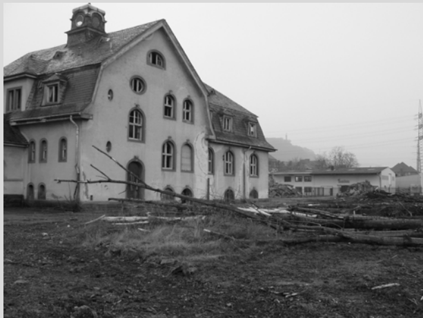
Bild 27: Putzbeschädigung durch Wassereinbruch
