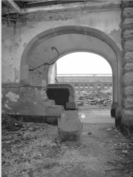
Bild 26: Zerstörung des historischen Sandsteinaufgangs des Verwaltungsgebäudes
