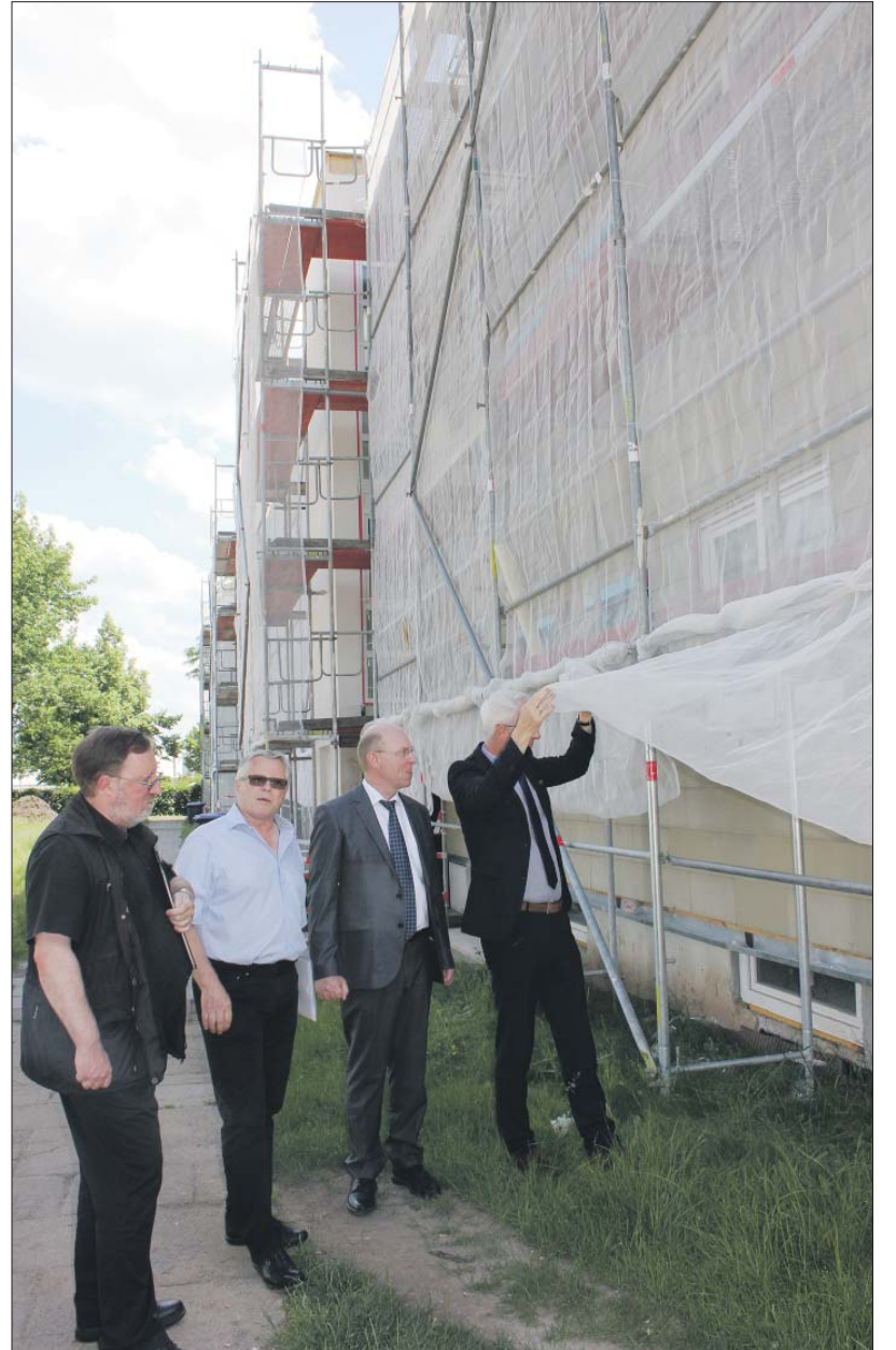
Auffrischung. Bei dem Rundgang mit Projektleiter Thomas Wagner, GBT-Prokurist Heinrich Masselter und Vorstandschef Dr. Stefan Ahrling (v. l.) schaut sich Oberbürgermeister Wolfram Leibe (rechts) die Fassade des Hauses Dauner Straße 5-6 an. Sie ist wegen einer Grundreinigung durch eine Plane geschützt. Foto: Presseamt/pe
