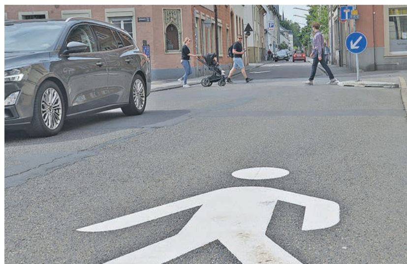
Anfahrt. Piktogramme und die verengte Fahrbahn sollen Autofahrer vor der Fußgängerquerung zum Bremsen veranlassen. Foto: Presseamt/kig
