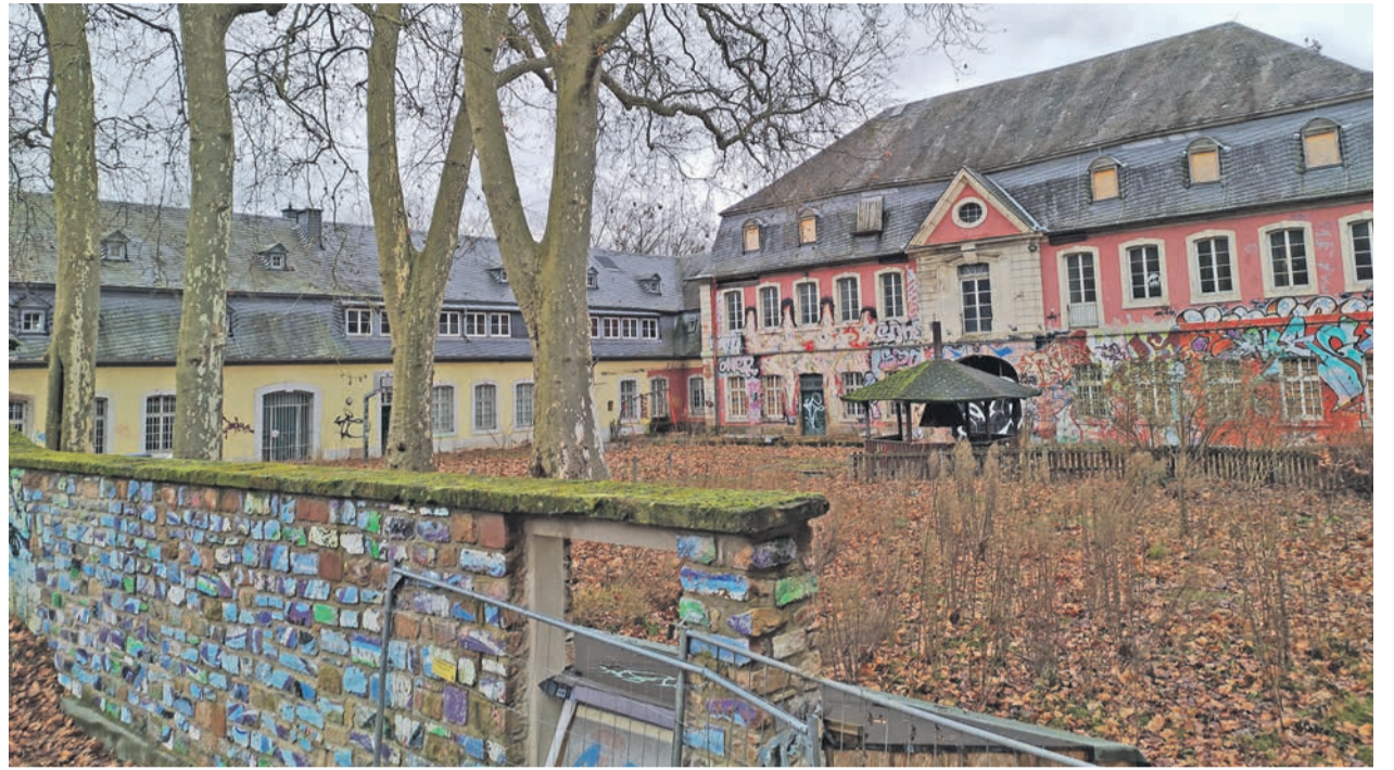
Zugewuchert. Noch ist nicht klar, wie es mit dem 2019 aufgrund gravierender Baumängel geschlossenen Exhaus-Gebäude in der Zurmaiener Straße weitergeht. Archivfoto: Presseamt
