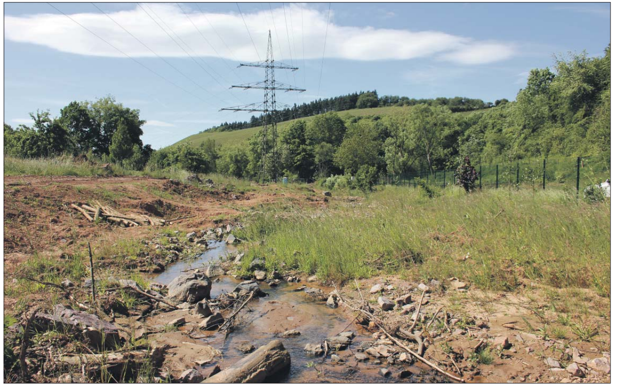
Naturnah. Die Renaturierung des Avelerbachs wird in drei Bauabschnitten umgesetzt, von denen der erste 2012 begann. In zwei Monaten soll das Projekt abgeschlossen sein. Foto: Presseamt
