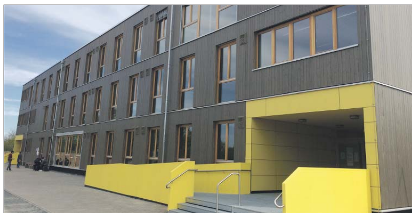
Übergangslösung. Der mobile Holzbau der IGS bietet Platz für rund 540 Schüler. Später dient er als Grundschule in Trier-West/Pallien. Archivfoto: PA
