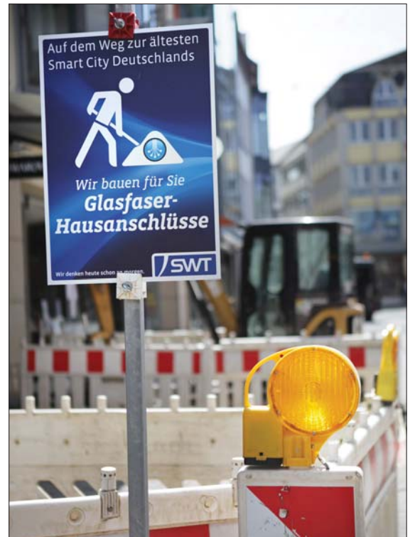
Lockdown genutzt. Zu Beginn der Coronakrise konnte die Stadtwerke einige Kunden an ihr Glasfasernetz anschließen, darunter in der Grabenstraße in der Innenstadt. Foto: Stadtwerke
