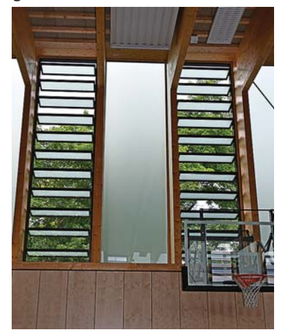
Lamellen. Die senkrecht angeordneten, großflächigen Fenster sorgen für Helligkeit und gute Belüftung.
