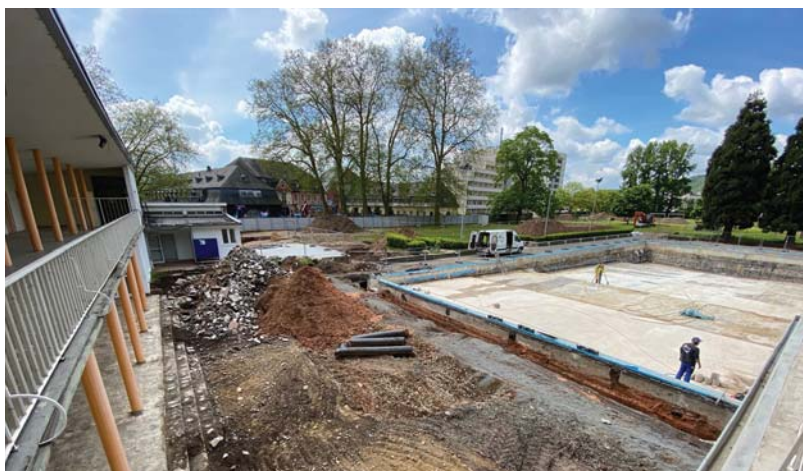
Entkernt. Derzeit ist in der Baugrube im Nordbad das freigelegte Fundament des großen Beckens zu sehen. Foto: Stadtwerke
