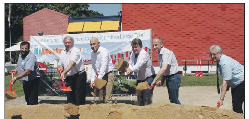
In Trier-Nord beginnen die rund 5,2 Millionen Euro teuren Bauarbeiten zur Vergrößerung der Jugendherberge. Künftig stehen dort 370 Betten zur Verfügung. Zudem wird der Altbau modernisiert und durch einen Wintergarten erweitert. Dann gehört das Haus zu den größten deutschen Jugendherbergen. Beim Spatenstich begrüßte Leiter Georgios Tsanis (l.) viele Gäste, darunter Baudezernent Andreas Ludwig (r.) und Peter Schuler, Präsident der Jugendherbergen in Rheinland-Pfalz und im Saarland (2. v. l.). Foto: Jessica Braun
