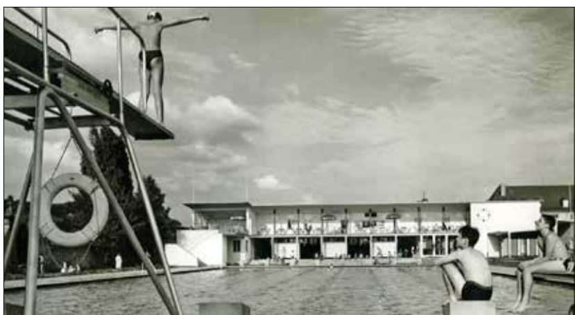
Sprung ins Wasser. Die Sanierungskosten für das über 60 Jahre alte Nordbad werden auf 4,45 Millionen Euro beziffert. Die Stadt hofft hierfür auf einen Zuschuss aus einem Bund-Länder-Sonderprogramm. Archivfoto: privat
