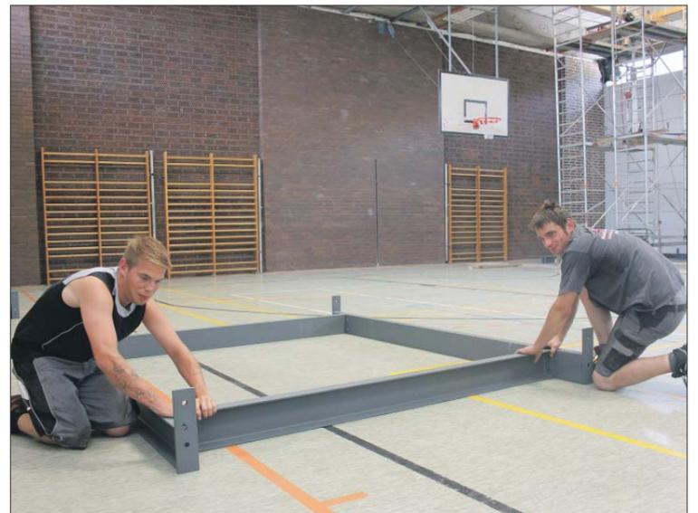
Schweißtreibend. Die Stahlträger werden verschraubt und anschließend zur Stabilisierung an die Decke angebracht.
