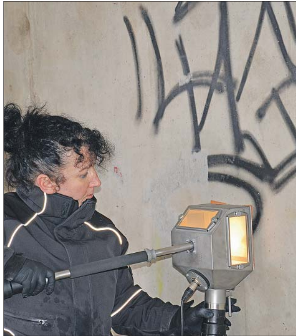
Sauber. Je nach Untergrund rücken die BÜS-Mitarbeiter den Schmierereien mit unterschiedlichen Verfahren zu Leibe. Während Tatjana Schaffrath an der Betonfassade ein Vakuumstrahl-Gerät einsetzt (links), greift Alexander Denkov am Metallcontainer zu chemischen Lösungsmitteln. Fotos: Presseamt/kg
