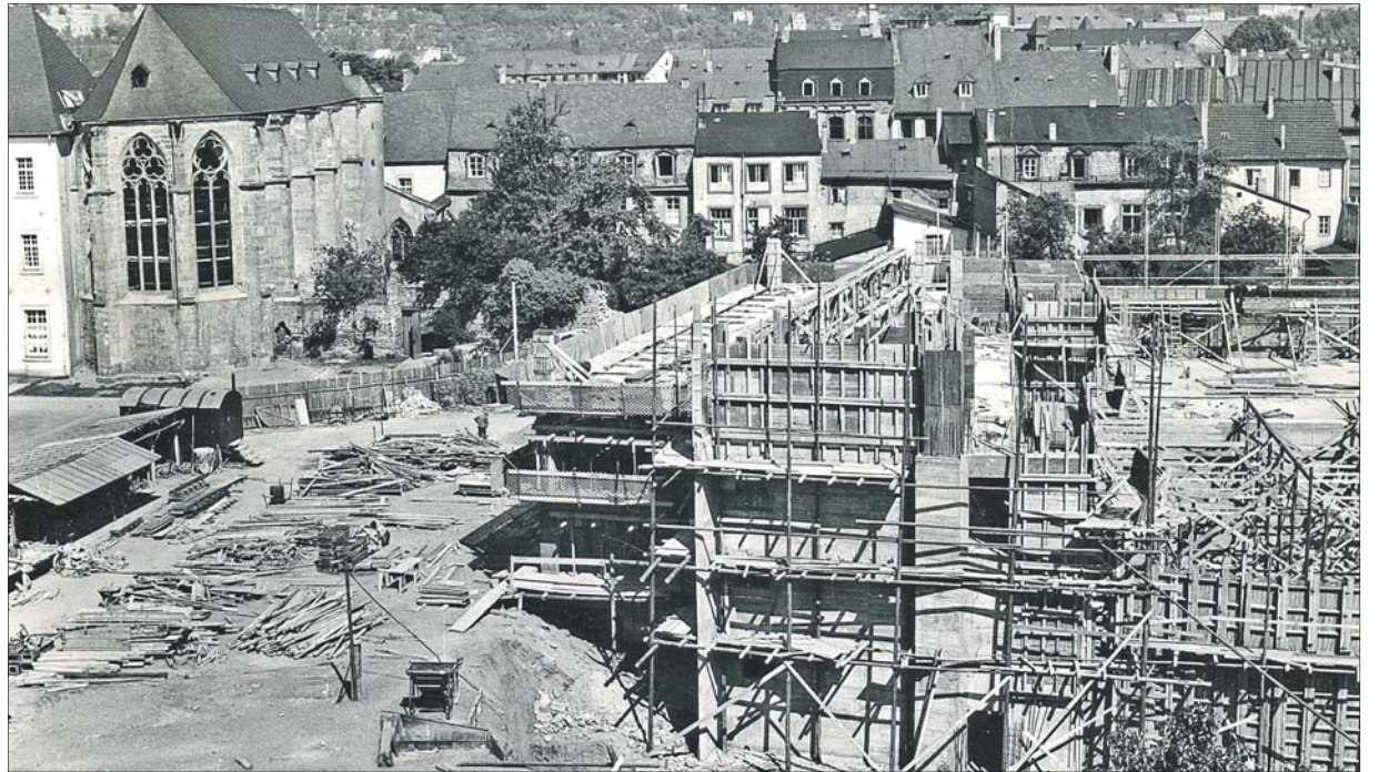
Baustelle. Das Anfang der 1960er-Jahre errichtete Theater ist mittlerweile stark sanierungsbedürftig. Um den Charakter des Gebäudes zu erhalten, wollten die Grünen es unter Denkmalschutz stellen lassen. Foto: Stadtarchiv
