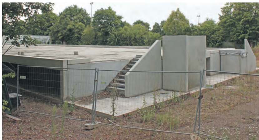
Stillstand. Die Baustelle der Kita Pfalzel ist im Dornröschenschlaf. Das hängt auch mit Lieferengpässen bei wichtigen Baustoffen zusammen. Foto: PA/rlo
