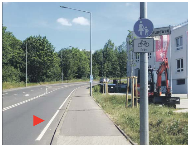
Steiler Anstieg. Der Trennstreifen auf der Kohlenstraße (Pfeil) garantiert den Abstand der Autos zu Fußgängern und Radfahrern auf dem Gehweg. Foto: Stadtplanungsamt
