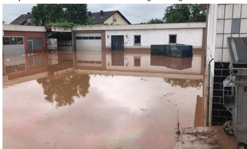
Land unter. Von den Hochwasser in Ehrang waren auch verschiedene Firmengrundstücke betroffen, darunter in der Quinter Straße. Foto: privat
