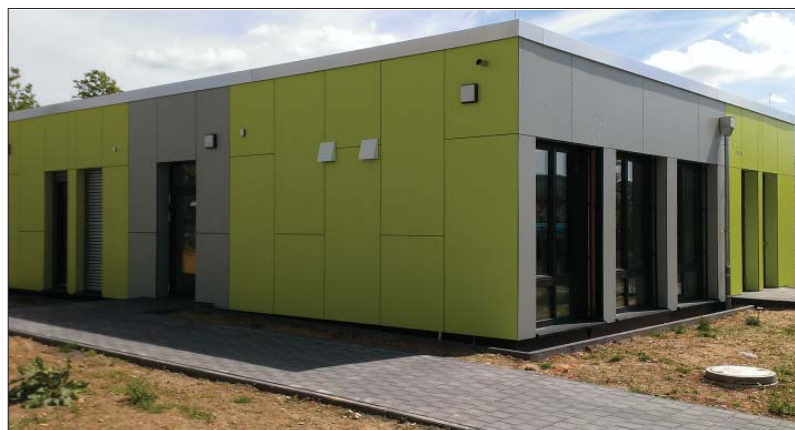
In einem Neubau in Holzrahmenbauweise hinter der Mehrzweckhalle stehen der Grundschule Tarforst auf rund 170 Quadratmetern zwei neue Klassenzimmer, ein Förderraum sowie ein kleiner Sanitärbereich zur Verfügung. Der Bau wurde nötig durch steigende Schülerzahlen. Das Gebäude hat eine Heizung mit Luft-Wasser-Wärmepumpe, eine kontrollierte Lüftung mit Wärmerückgewinnung und eine hochwertige Dämmung. An den Kosten von rund 580.000 Euro beteiligte sich das Land mit 210.000 Euro. Mit der grau-grünen Fassade passt das Gebäude gut zum benachbarten Schulhauptgebäude. Foto: Gebäudewirtschaft
