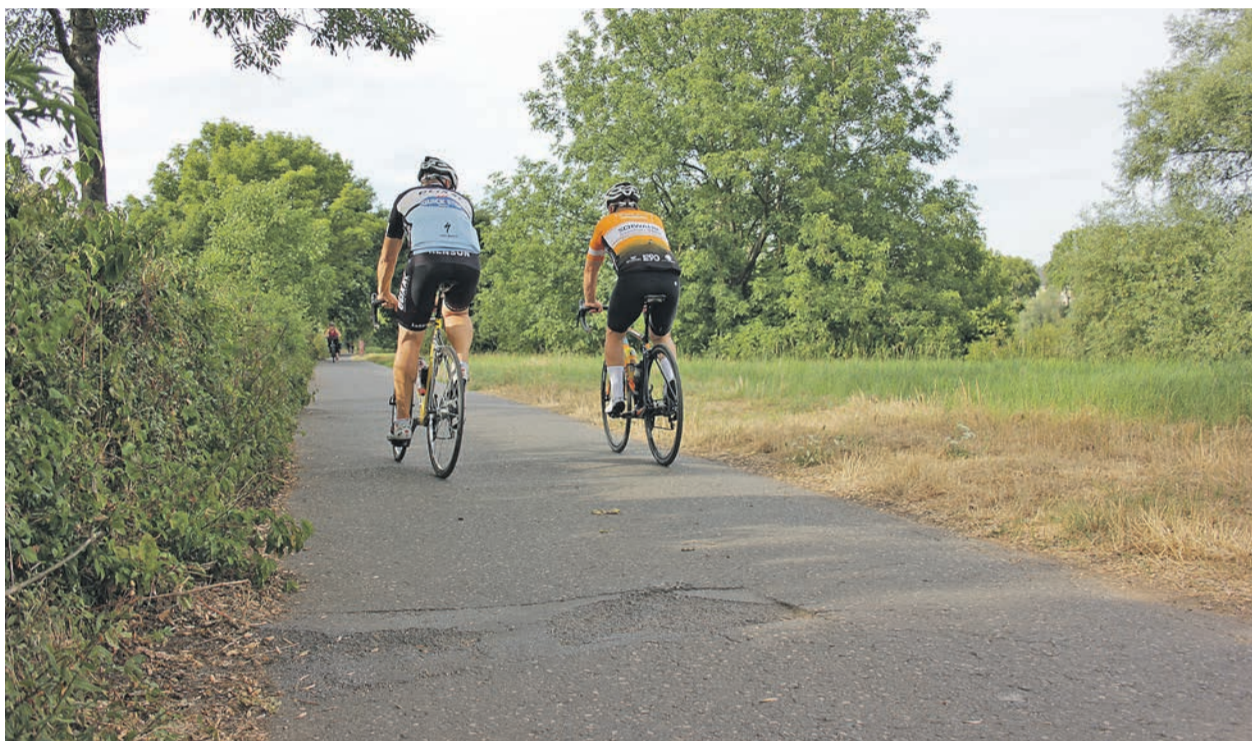
Auf Tour. Unebenheiten auf dem Moselradweg, wie hier in der Nähe der Konrad-Adenauer-Brücke, sollen durch die Oberflächensanierung so gut wie möglich behoben werden. Foto: Presseamt/bau
